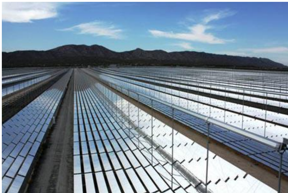
西班牙30MW的Puerto Errado 2光热电站
